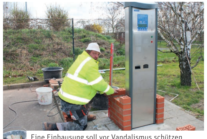
Eine Einhausung soll vor Vandalismus schützen.
